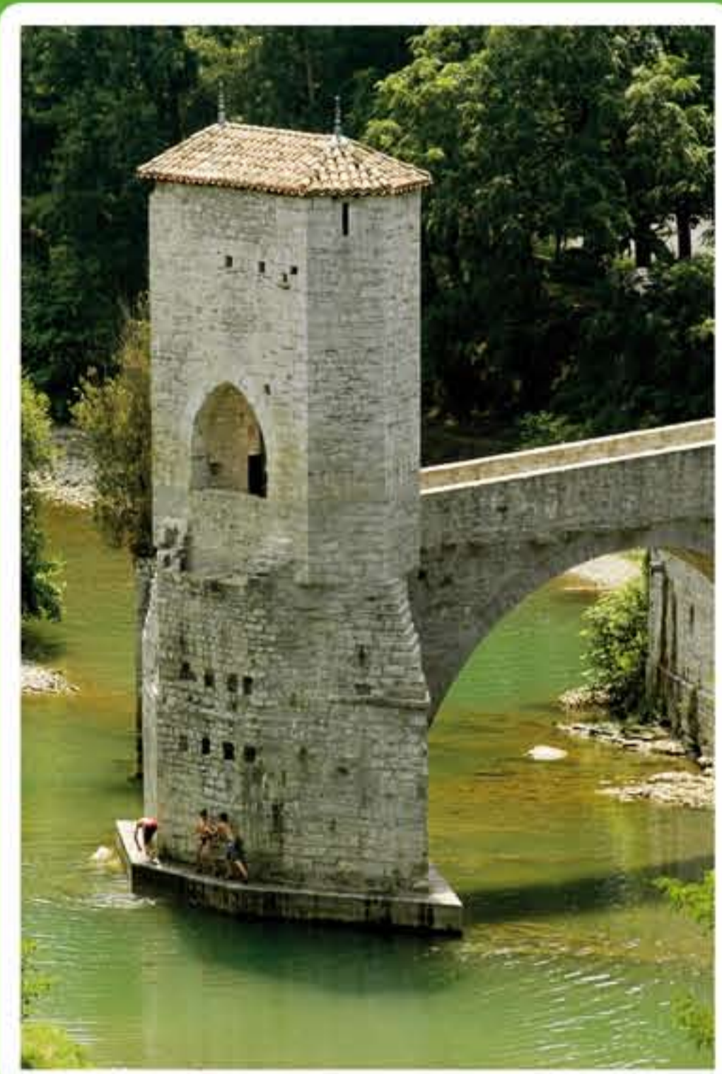
Pont de Sauveterre-de-Béarn © CDT64
